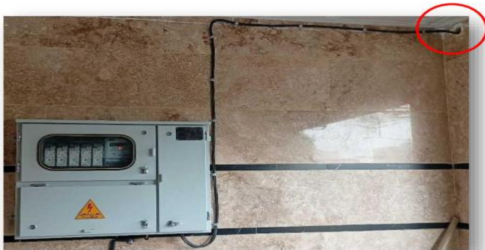
شکل ۲: موقعیت نصب لوله پی وی سی به قطر ۴۰ میلیمتر
